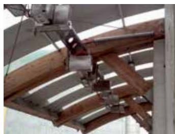
Sistema de cámaras
