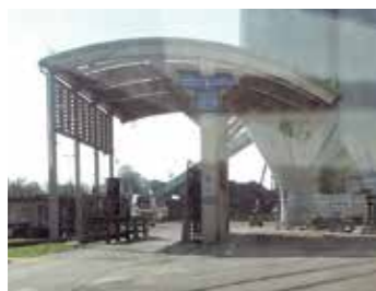
Sistema TMS en la instalación
